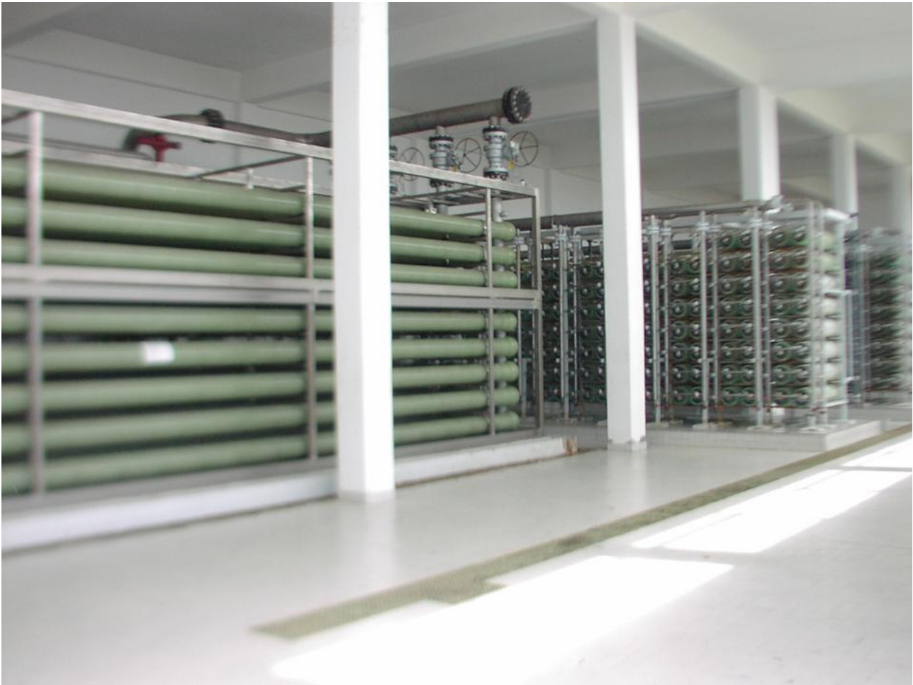
Estação de dessalinização de água
