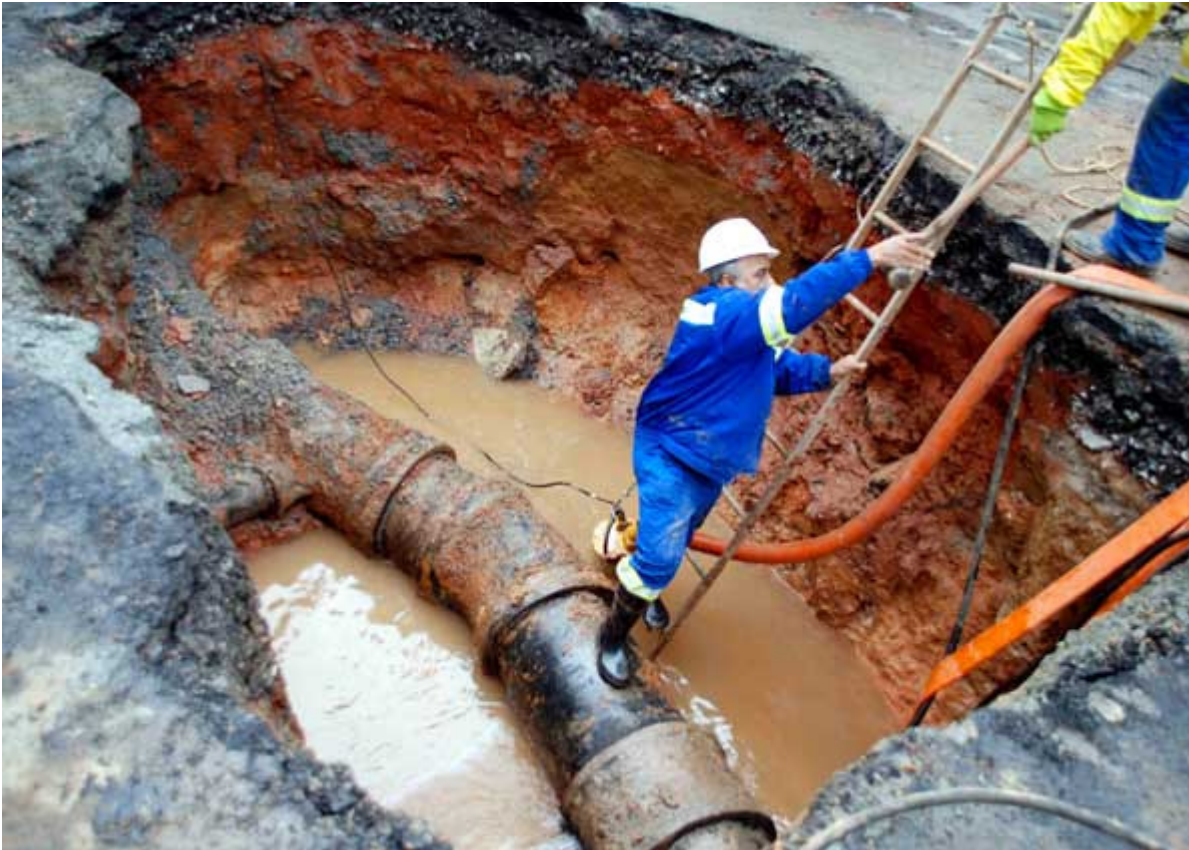
reparo em rede adutora
